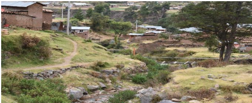
FIGURA N°03: SE APRECIA EL CAUCE DE LA QUEBRADA CACHIMAYO, ESTRANGULADO Y COLMATADO.
